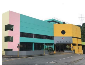
曹公潭戶外康樂中心
