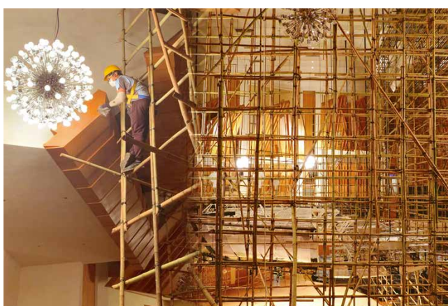
香港文化中心因疫情而关闭，其间音乐厅搭起六层楼高的棚架，进行天花板和回音板的清洁工程
