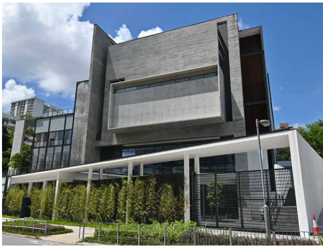
车公庙体育馆由二零二零年九月十七日起开放予公众使用，是本署在沙田区第七个体育馆，为居民提供多元化的康体设施。
